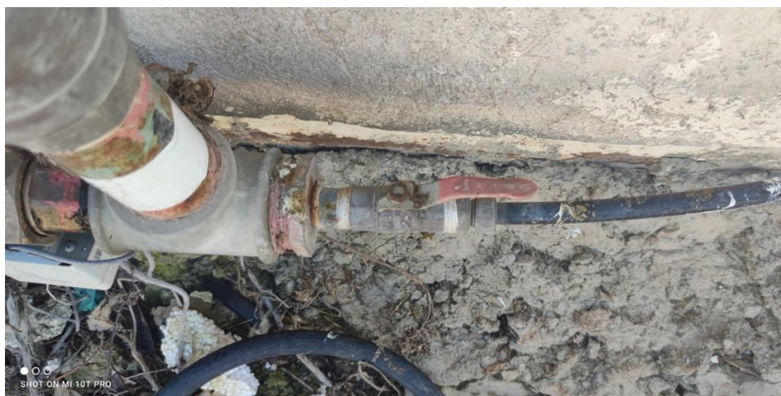
תיאור: התחברות לא חוקית לשעון המים של המועצה במחסני מל"ח
