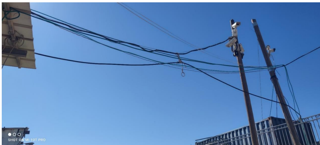
תיאור: התחברות לא חוקית לשעון המים והחשמל של המועצה במחסני במל"ח
